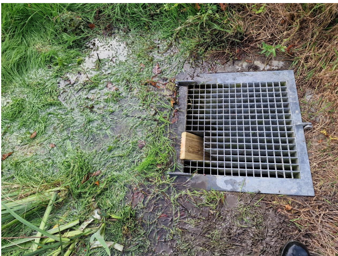
Aan de buitenzijde van het rooster ziet het er zo uit. De plank is wel vastgezet.
