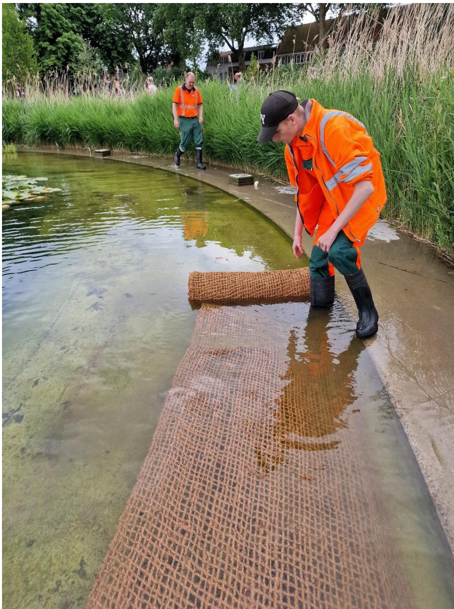
Op 25-6-2025 zijn we begonnen met het aanleggen van een moeras aan de rand van de Spiegelvijver.
